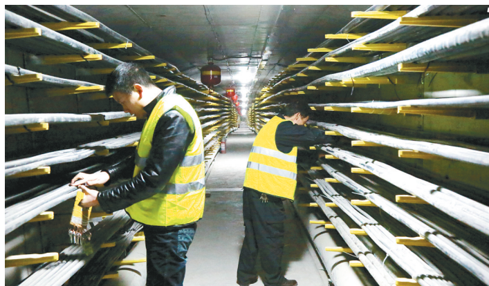
隧道电力巡查
