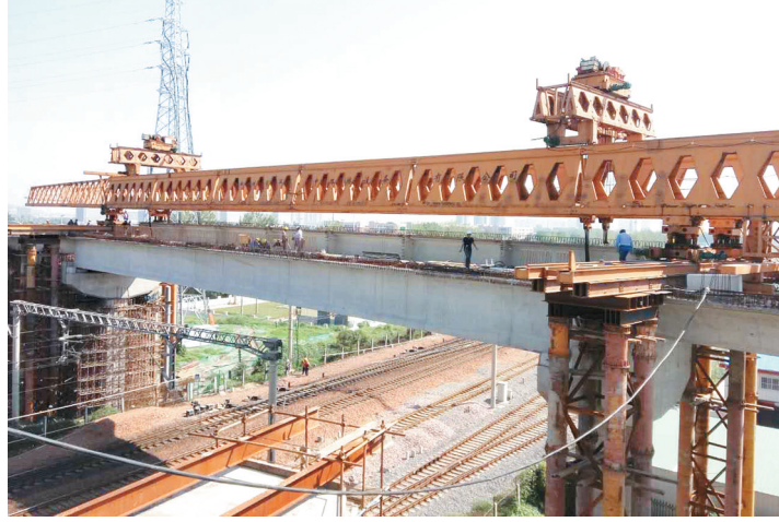
陇海路—107辅道立交南向向西匝道最后一片箱梁7日11时10分落定
