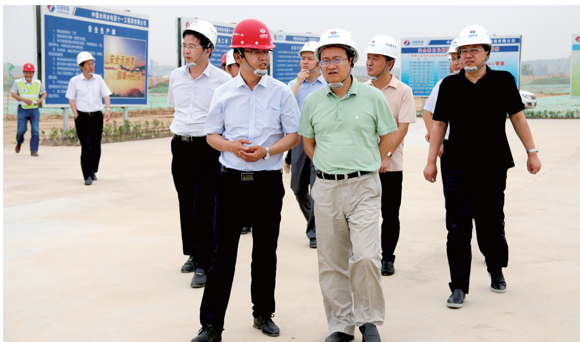
中国水利水电第十一工程局有限公司执行董事、总经理张玉峰(前排右)到公司园博园项目检查指导。项目经理高东斌(前排左)汇报工程进度。
