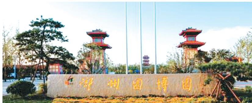
南入口大门为园博园主入口,向北经园博广场、同心湖与主山轩辕阁相望。建筑形式源于世界文化遗产——中岳汉三阙,以“汉阙”作为景观造型大门,充分突出中国传统文化氛围,符合本届“文化园博”的主题。南大门高18.8米,内部采用钢混结构,外部为传统造型与纹饰,典雅精美,华
