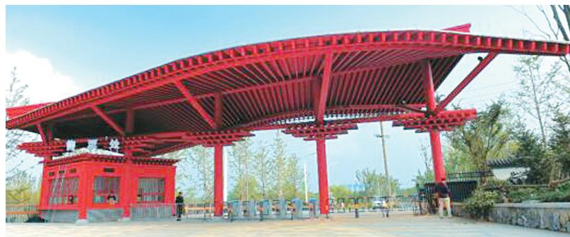
西入口主体建筑地上一层,建筑面积366.57平方米,大门层高9.583米,结构形式为钢框架结构,大门为“中原红”色彩。
