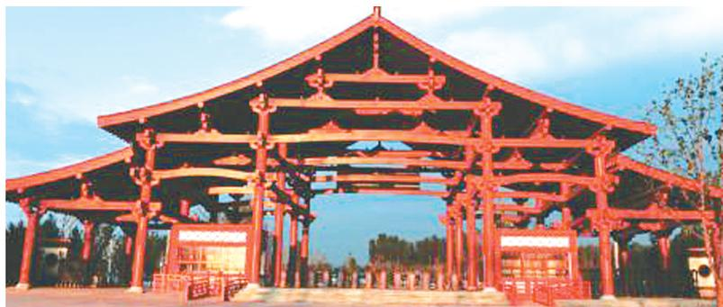
东入口主体建筑为地上一层,建筑面积为437.7平方米,高度为5.3米,钢框架结构,采用中国传统的抬梁式屋顶形式,铜瓦屋面,配以“中原红”的大门色彩,运用体现中原文化的礼乐元素,呈现出简洁大气的特点,与园内的传统建筑相呼应。大门举架平缓,出檐深远,斗拱等构件精巧别致,两侧树木掩映,突出东大门,增强对人流的引导作用。东门广场
