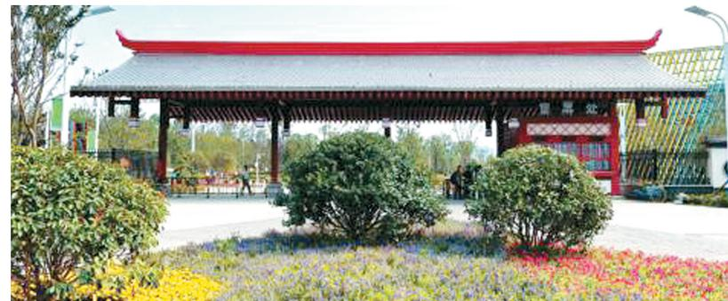
北入口建筑面积为190平方米,地上一层,高度5.37米,结构形式为钢框架结构,大门为“中原红”色彩,金属瓦屋面,现代新中式风格,造型简洁大方。北入口广场约2200平方米,广场周边设有售票处、检票口、游览指示图、交通指示牌、生态停车场等设施,方便人流集散。新港花街和月季花圃位于北入口
