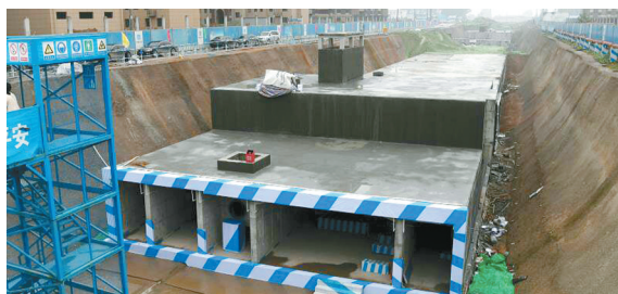
惠济区花园口镇地下综合管廊工程现场
