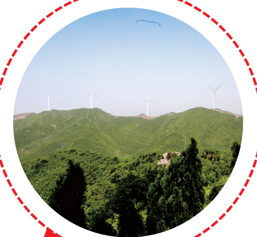
登封高新技术产业风电项目
