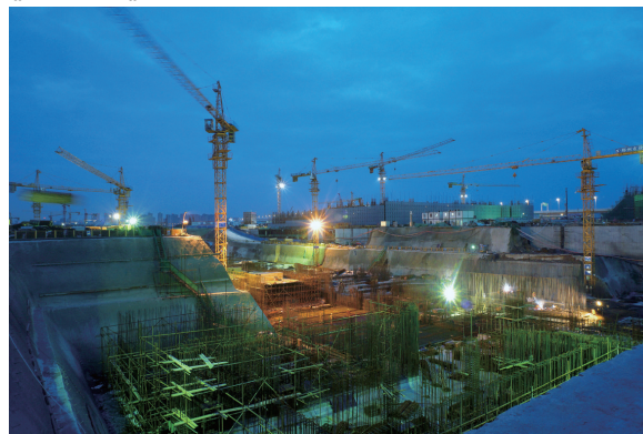
《建设中的“四个中心”》郭晓光 摄
