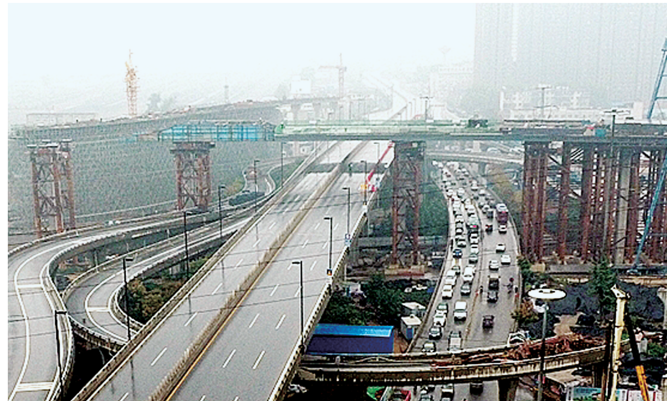
农业路高架主线桥跨京广快速路顶推作业现场
