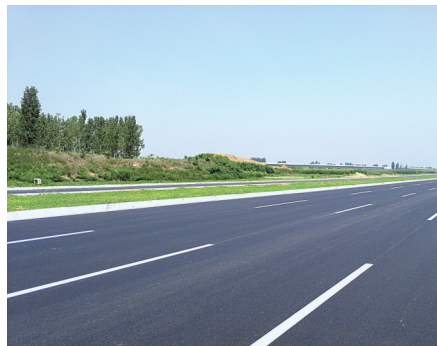
国道107线郑州境东移改建(二期)工程
