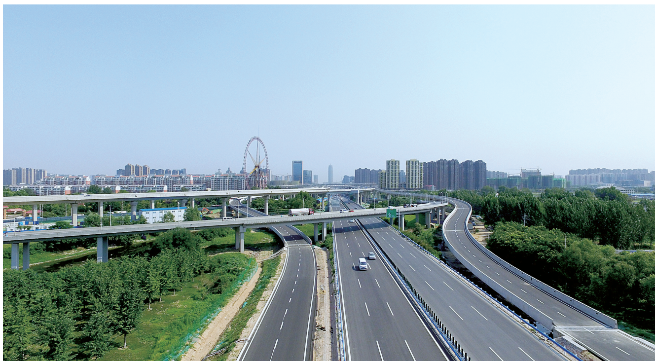
机场高速改扩建工程通车
