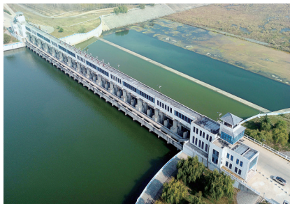
石梁河水利枢纽
