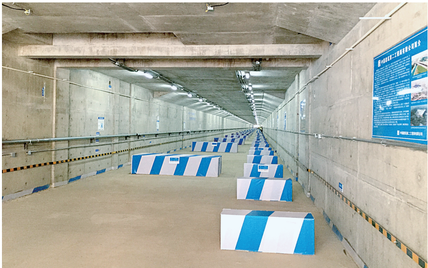
花园口镇地下综合管廊
