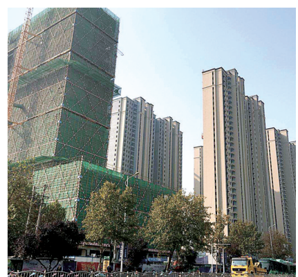
在建的中原区赵仙垌改造项目
