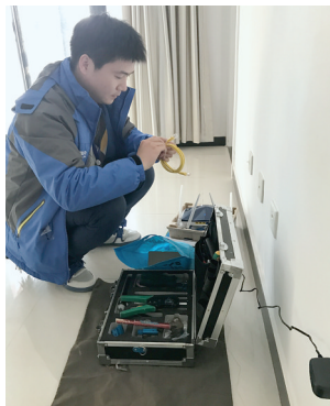
郑州移动装维人员正在调试网络
