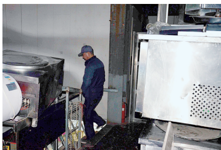
用于疏散逃生的楼梯口存放大量货物
