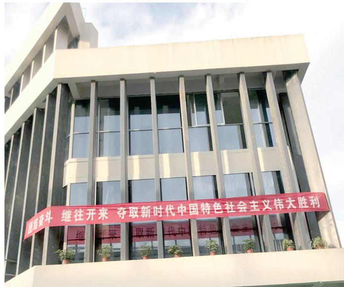
永平路便民服务中心预计明年2月完工
