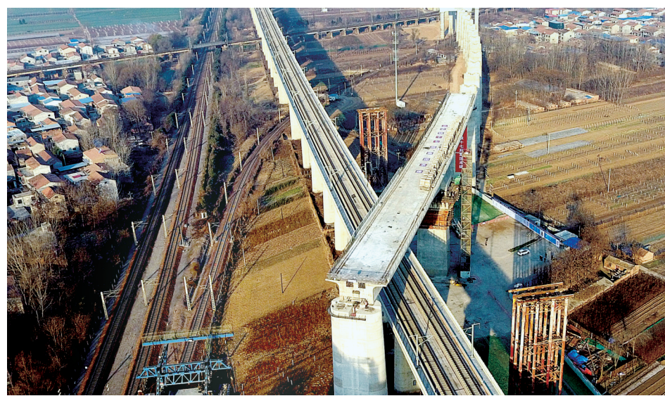
转体成功后的商合杭高铁跨郑徐高铁T构梁 新华社发
