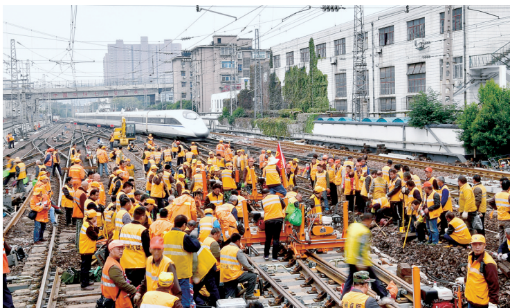
2017年10月11日,郑州火车站开始进行木质道枕的更换,33天的施工期将影响1200余列车,但火车站并未停运,包括高铁在内的大部分车辆仍然正常通行。
