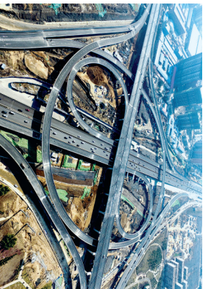
3月8日 航拍的北三环东三环立交，随着东三环南北贯通，郑州三环高架全面闭合。
