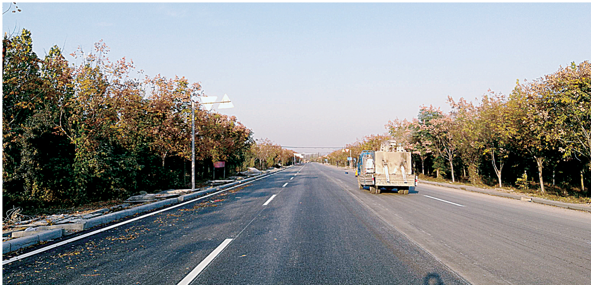
荥阳X032桃贾路大修主体工程完工通车
