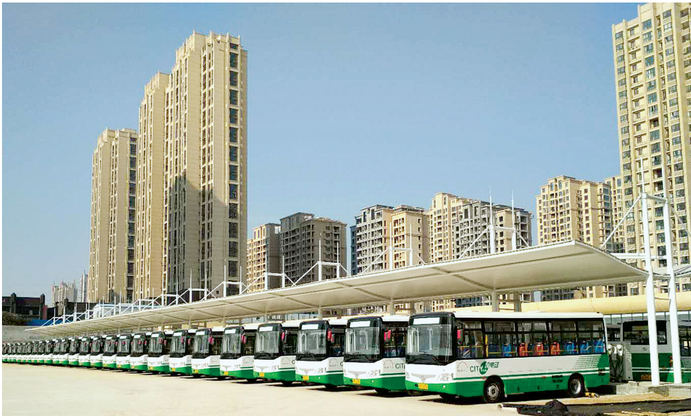
建成投入使用的充电站
