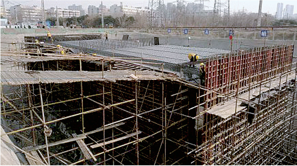
下穿铁路箱桥预制施工
