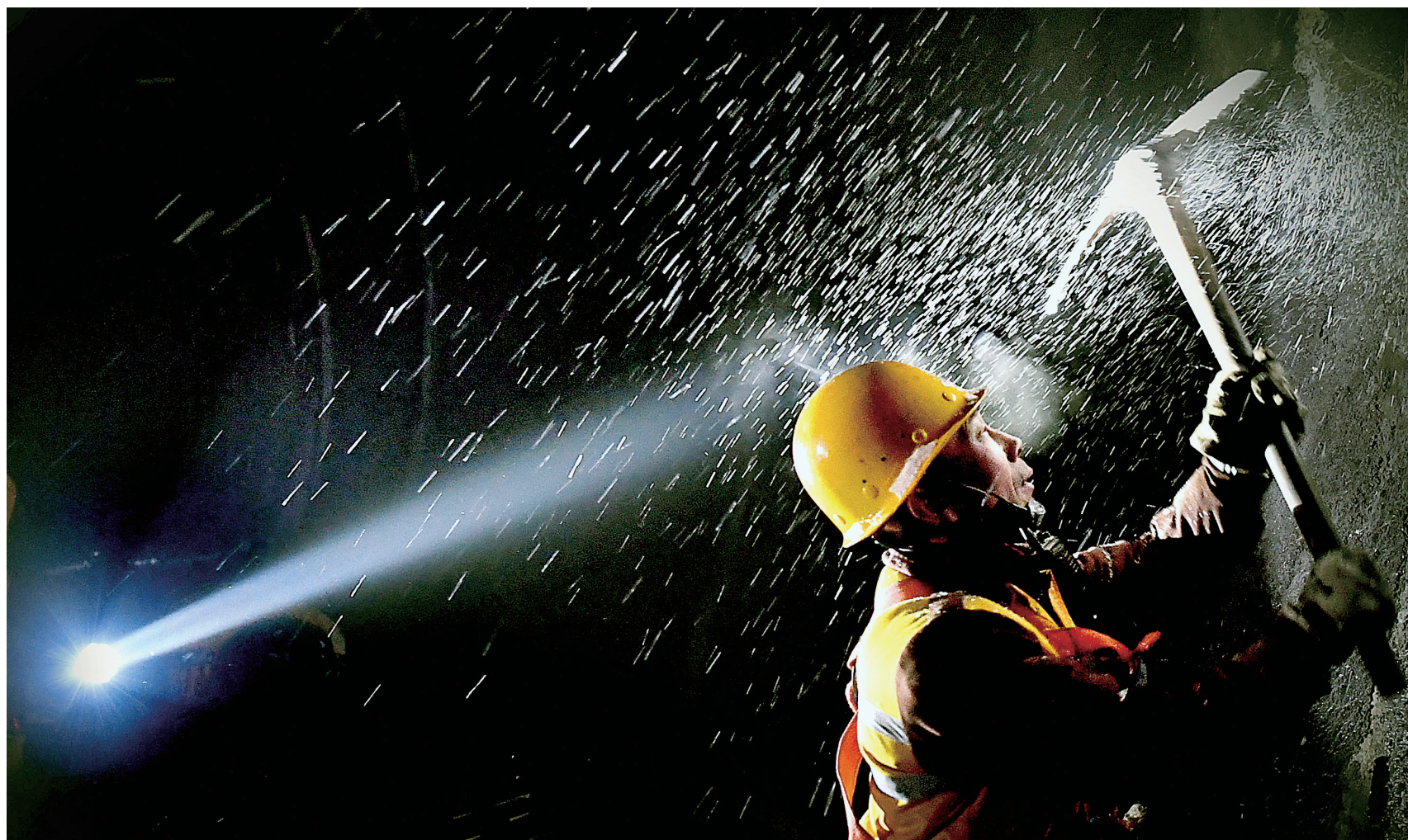
三门峡陇海线观音堂隧道,一位铁路打冰人借助灯光清除积冰 新华社 图
