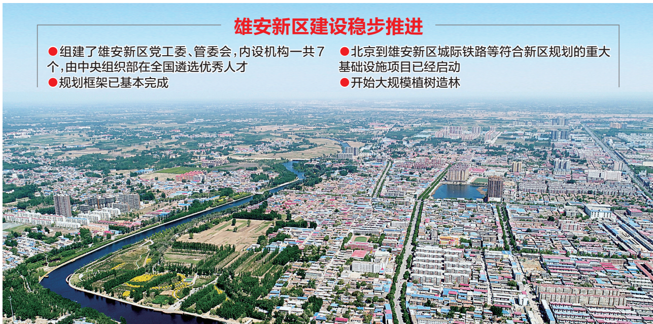
正在建设中的雄安新区 新华社发
