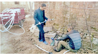
自来水管道升级
