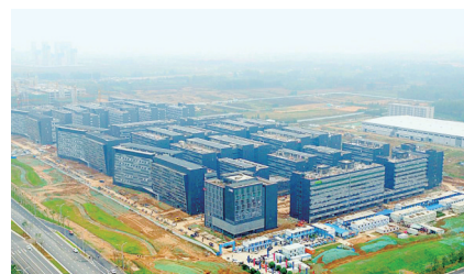
位于航空港实验区的手机产业园 通讯员 马国樑 图
