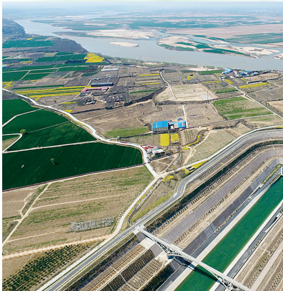
在整个南水北调中线工程建设中,穿黄工程被称为人类历史上最宏大的穿越大江大河的水利工程
