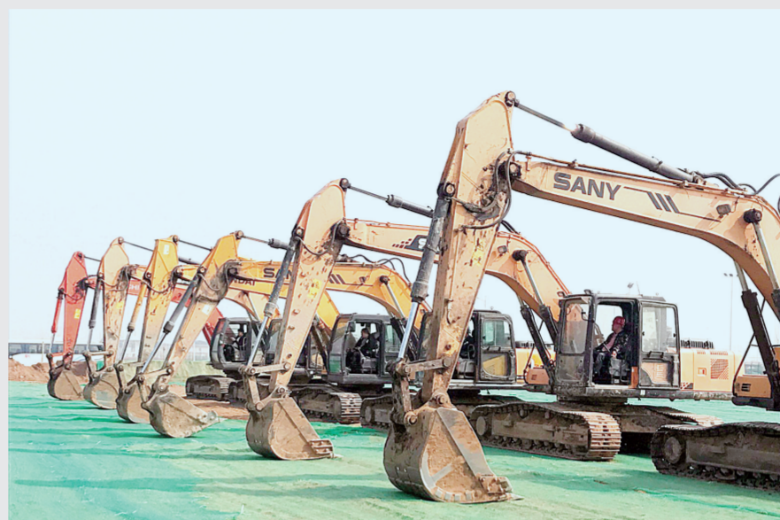
开工现场的挖掘机
