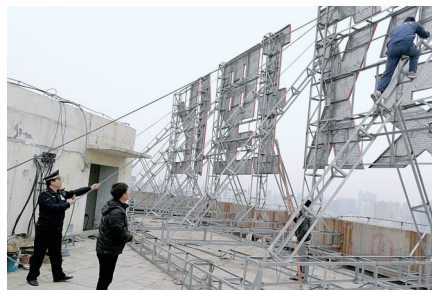
拆除违规屋顶标识招牌30余处。 记者 鲁慧 通讯员 常杰 文/图
