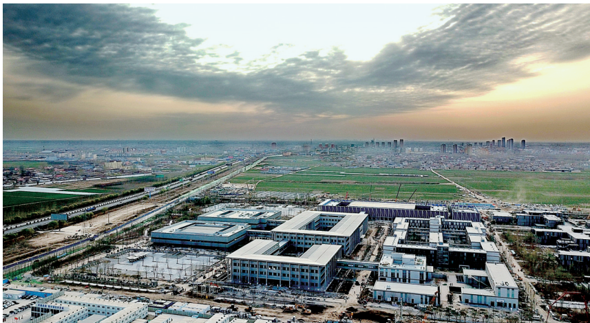
3月27日无人机拍摄下的雄安市民服务中心施工现场
