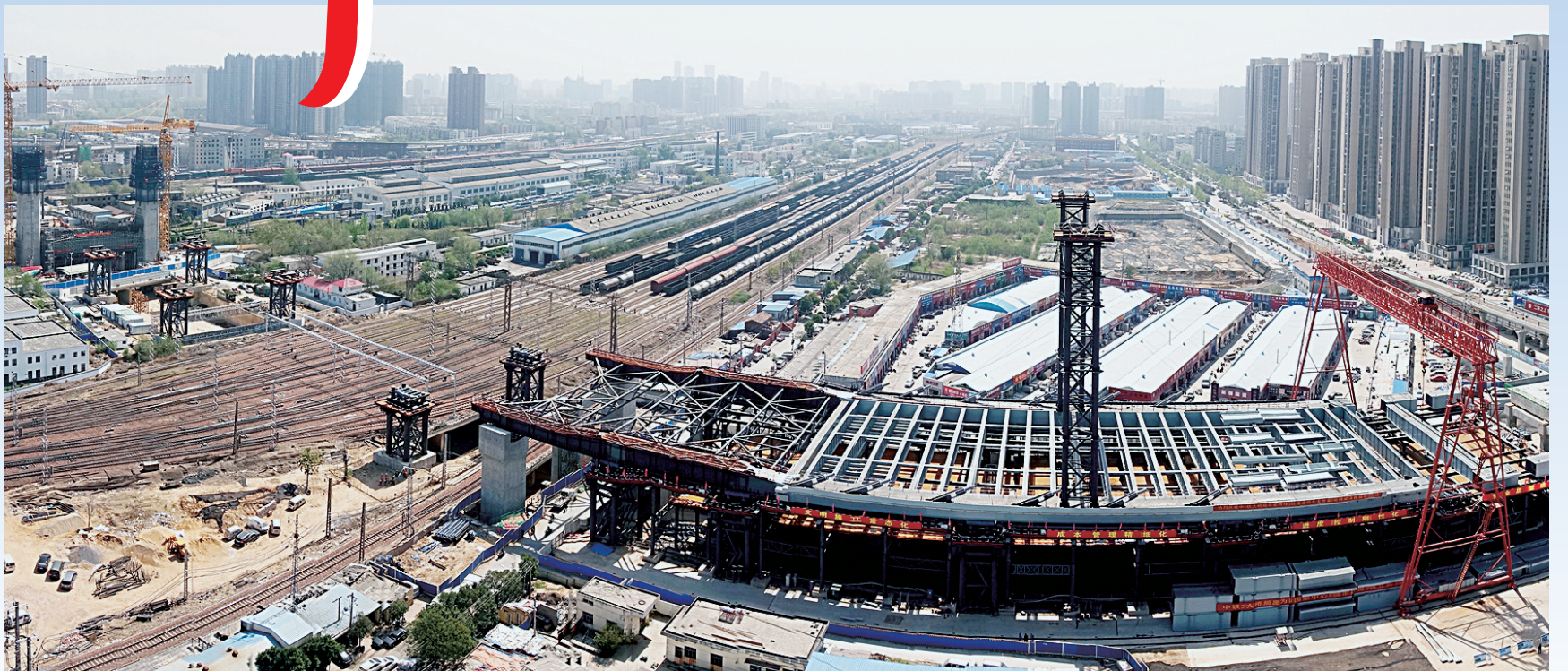
昨日,农业路高架郑北跨铁大桥开始钢梁顶推施工。记者 丁友明 图
