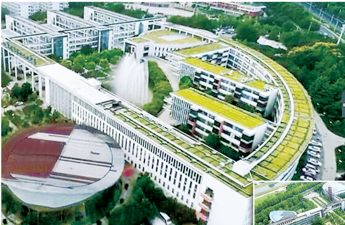
47中楼顶整治后
