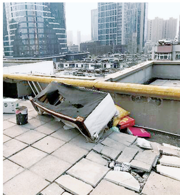
黄河路2号院24号楼楼顶整治前
