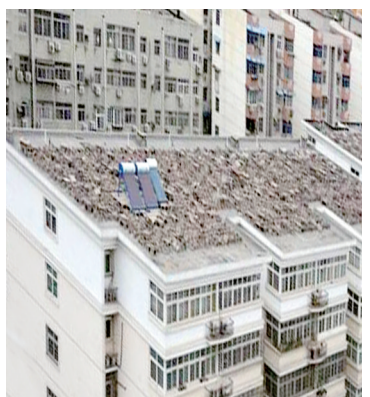
东明路29号院楼顶整治前
