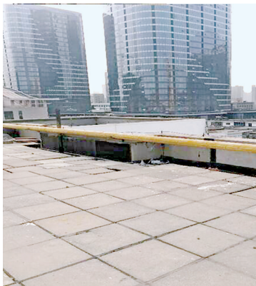
黄河路2号院24号楼楼顶整治后
