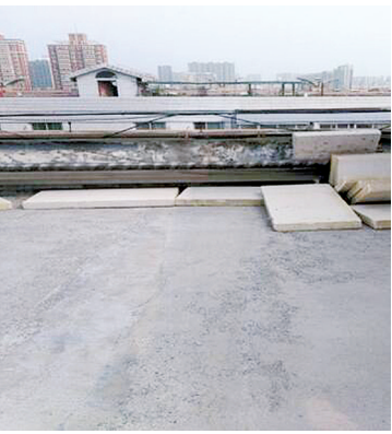
经二路北33号院楼顶整治后
