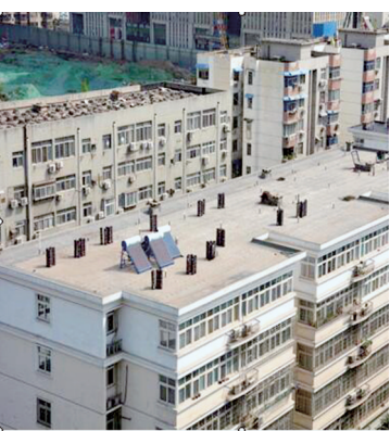
东明路29号院楼顶整治后
