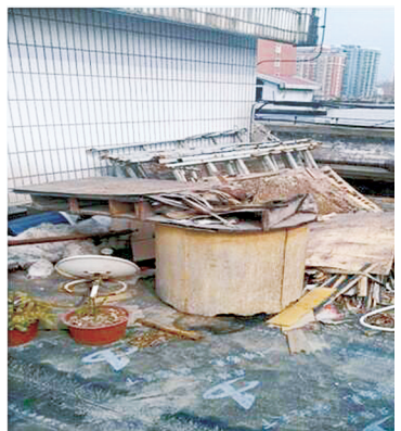
经二路北33号院楼顶整治前
