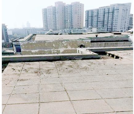
蜜蜂张40号院楼顶整治后
