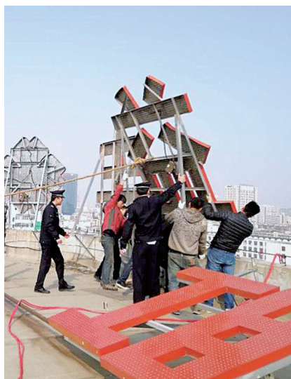
大学路街道拆除建筑屋顶标识招牌
