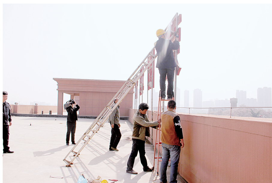
荥阳市城市管理局拆除楼顶招牌
