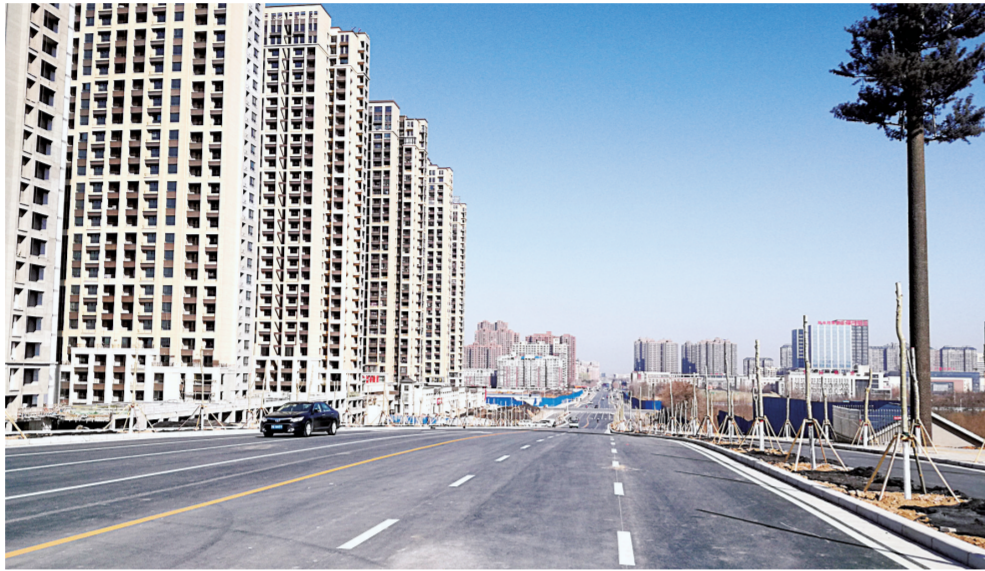
棋源路打通工程竣工
