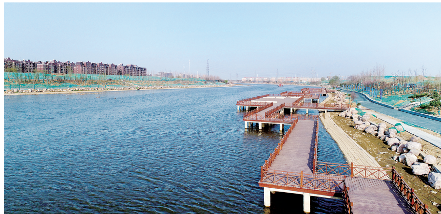
整治中新修的木栈道
