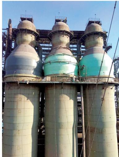
中铁装备沧州2500立方高炉三段式改造为四段式热风炉项目
