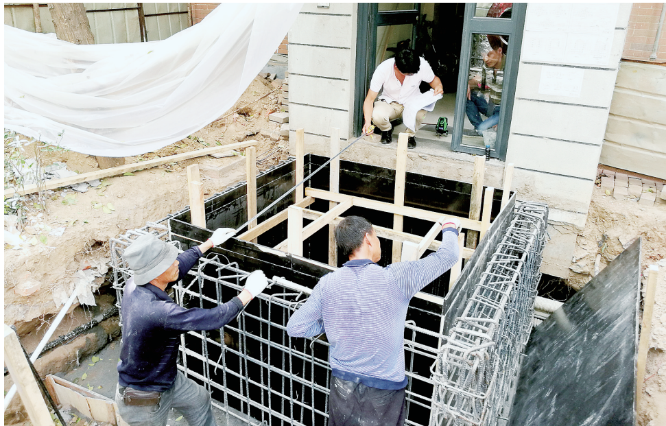
加装电梯施工现场
