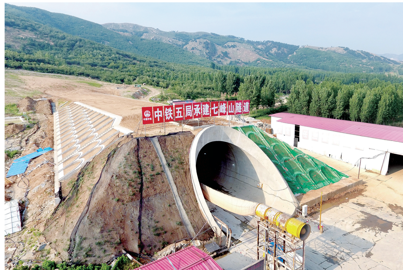
5月14日无人机航拍的位于河南方城县的郑万高铁七峰山隧道洞口 新华社发
