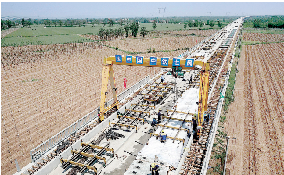
施工中的郑(州)万(州)高铁河南平顶山段颍河特大桥 新华社发
