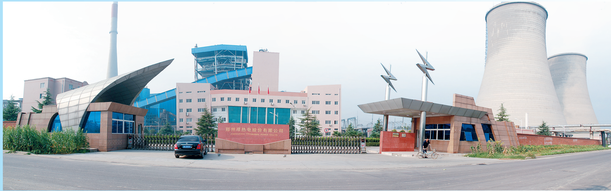
郑州泰祥热电股份有限公司厂区
