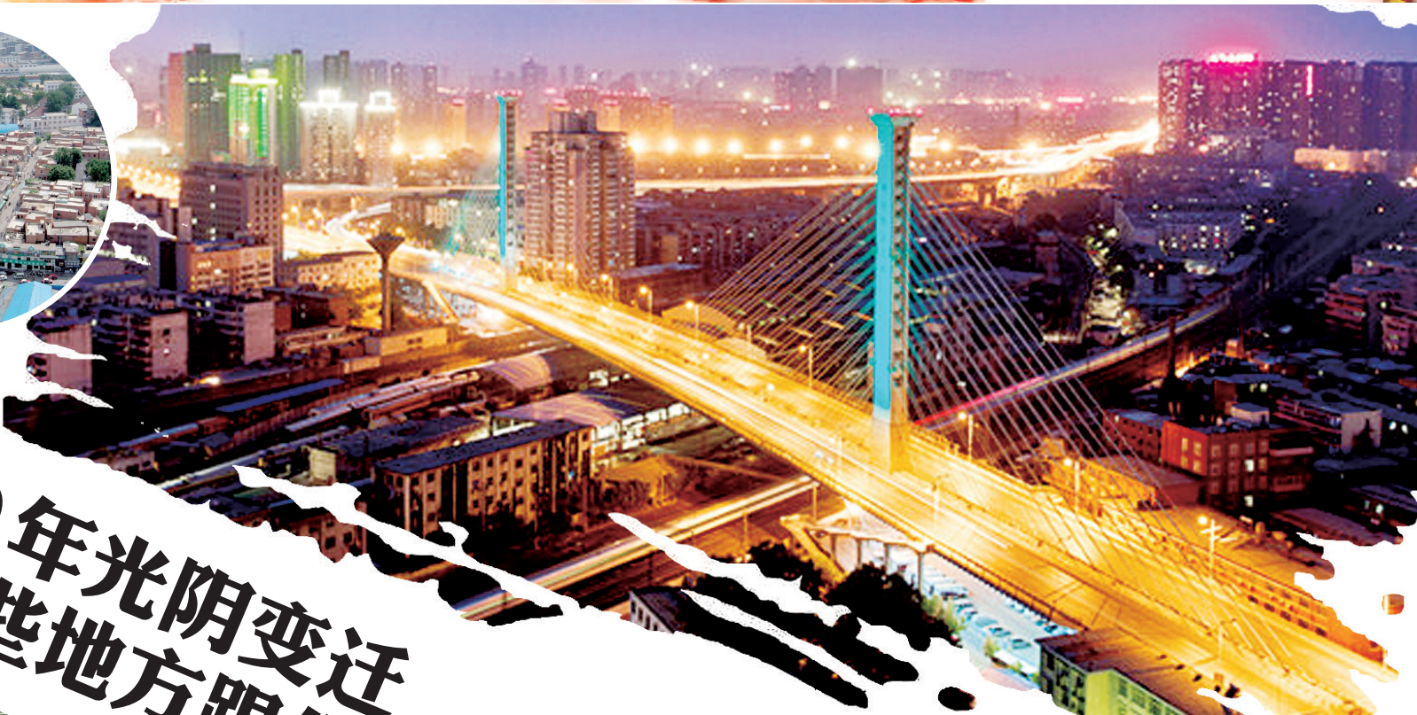
如今,解放路立交桥横跨京广铁路线
