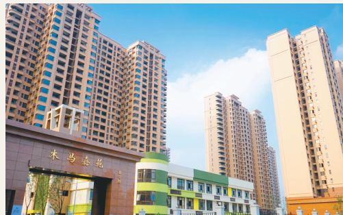
如今,建成后的木马村居民安置区
