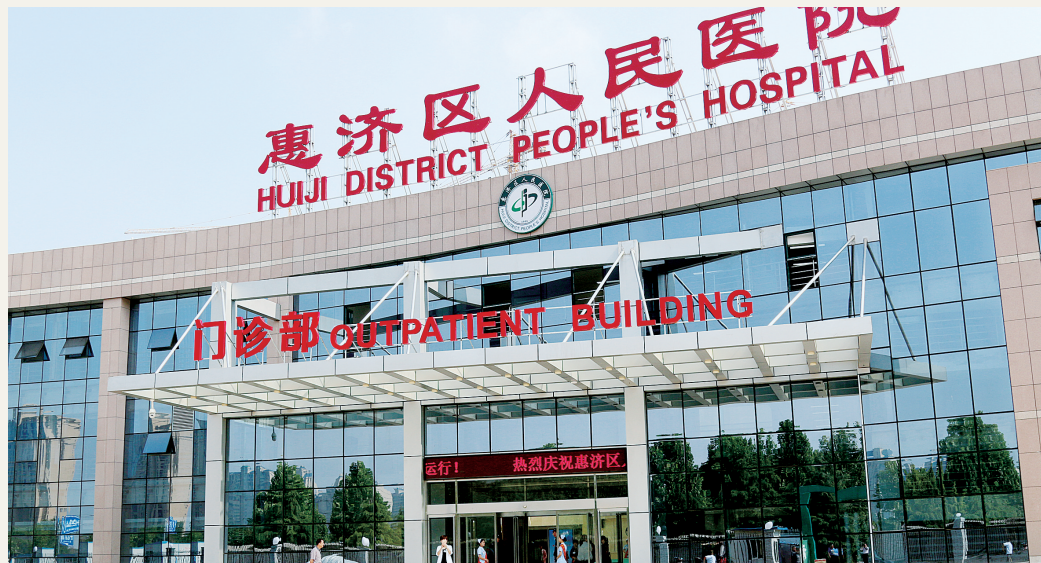
2016年,惠济区人民医院开元路院区开诊
