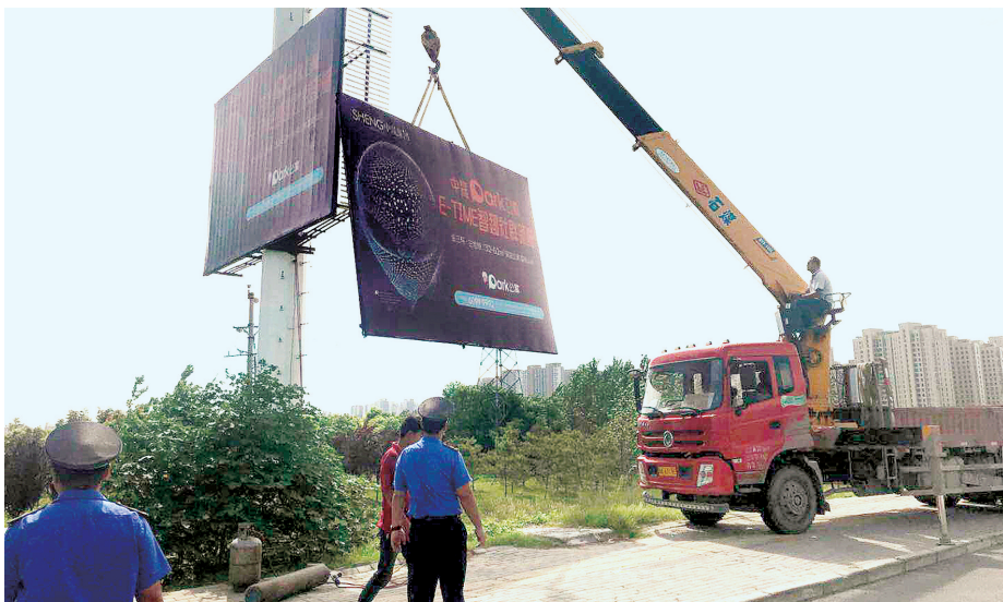
拆除高速口沿线广告牌
