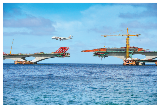
2018年6月24日,位于马尔代夫的中马友谊大桥主桥20号墩至21号墩之间的钢箱梁正在顶推。
