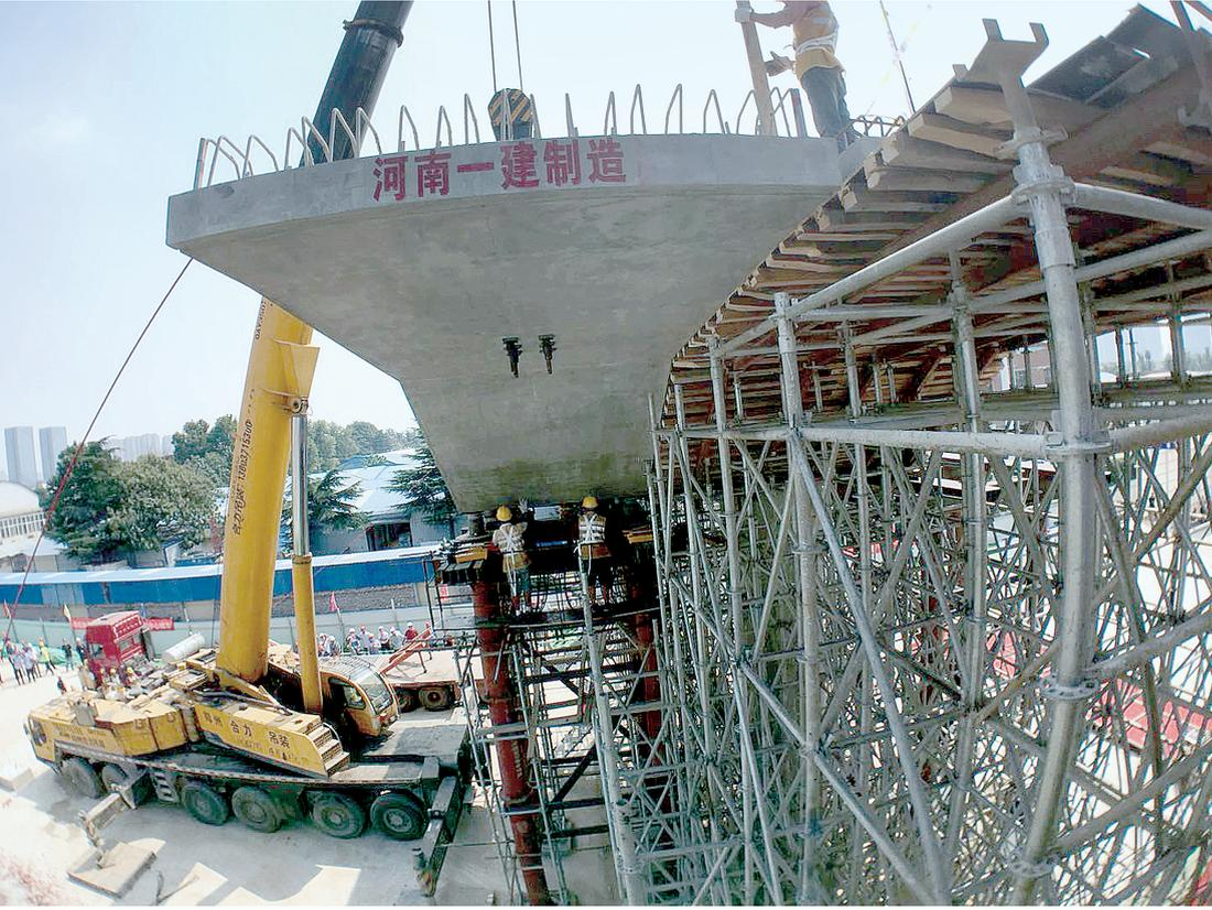
昨日,四环线及大河路快速化工程西四环涉铁路段开始第一片预制节段梁架设施工。首片预制节段梁长2.9米、宽16.5米、高2.2米,在未来一段时间内,将和其他4万多片不同形状预制梁一起,组合拼接成“四环大高架”。高架主线预计明年6月底具备通车条件。
