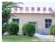
杨桥引黄渠首闸
