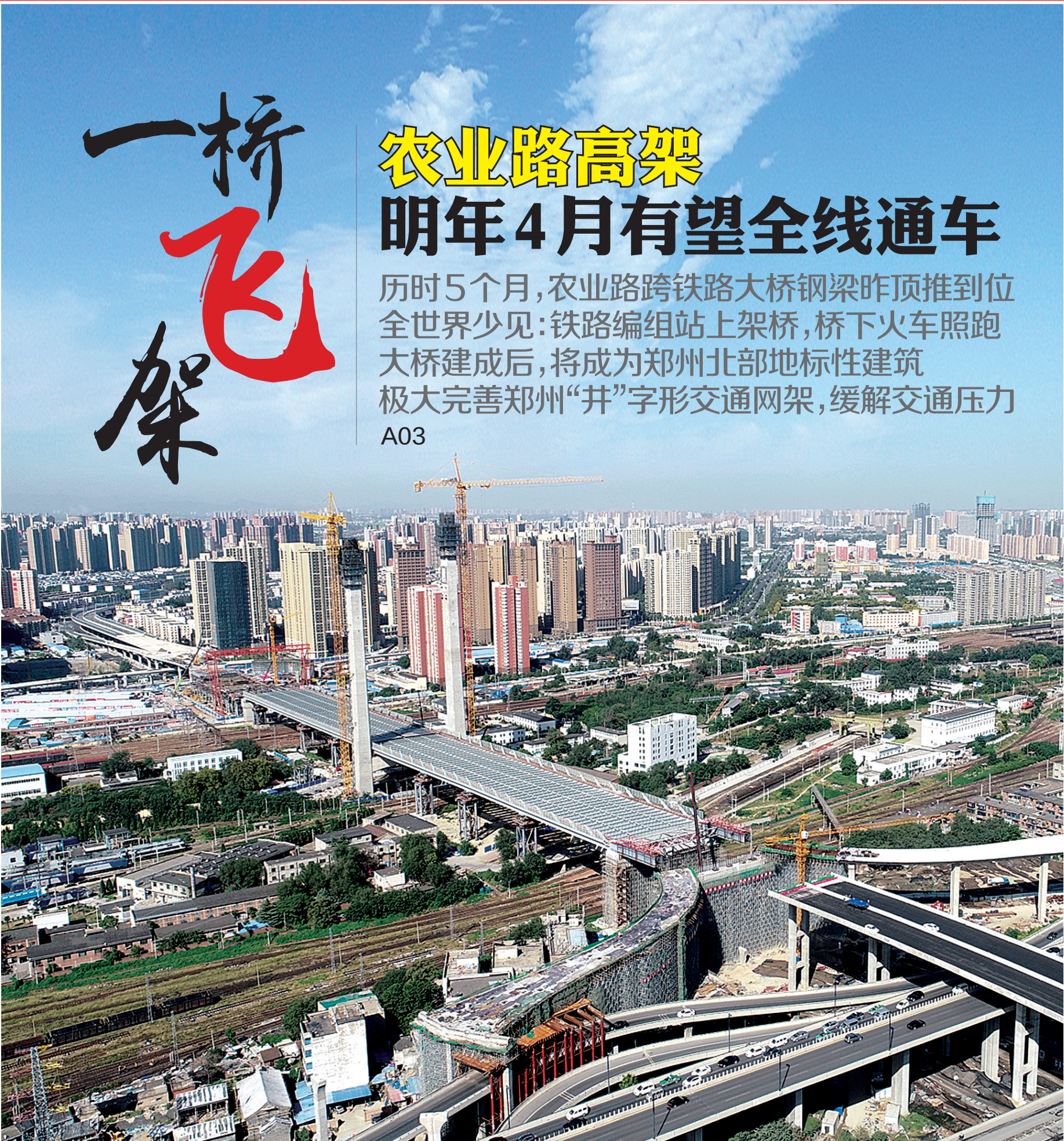
昨日,农业路快速通道跨铁路编组站大桥钢梁顶推到位。记者 丁友明 图
