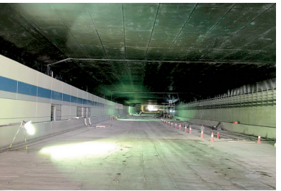
隧道开始内部附属设施施工
