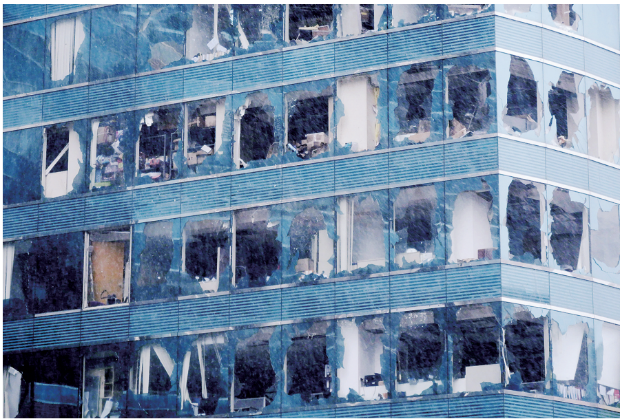
位于香港九龙半岛红磡海滨的一座写字楼,窗户玻璃破碎严重
